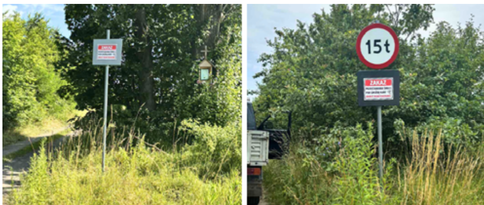
Montaż tablic informacyjnych przypominających o zakazie wyrzucania odpadów w miejscach szczególnie narażonych na zanieczyszczanie
